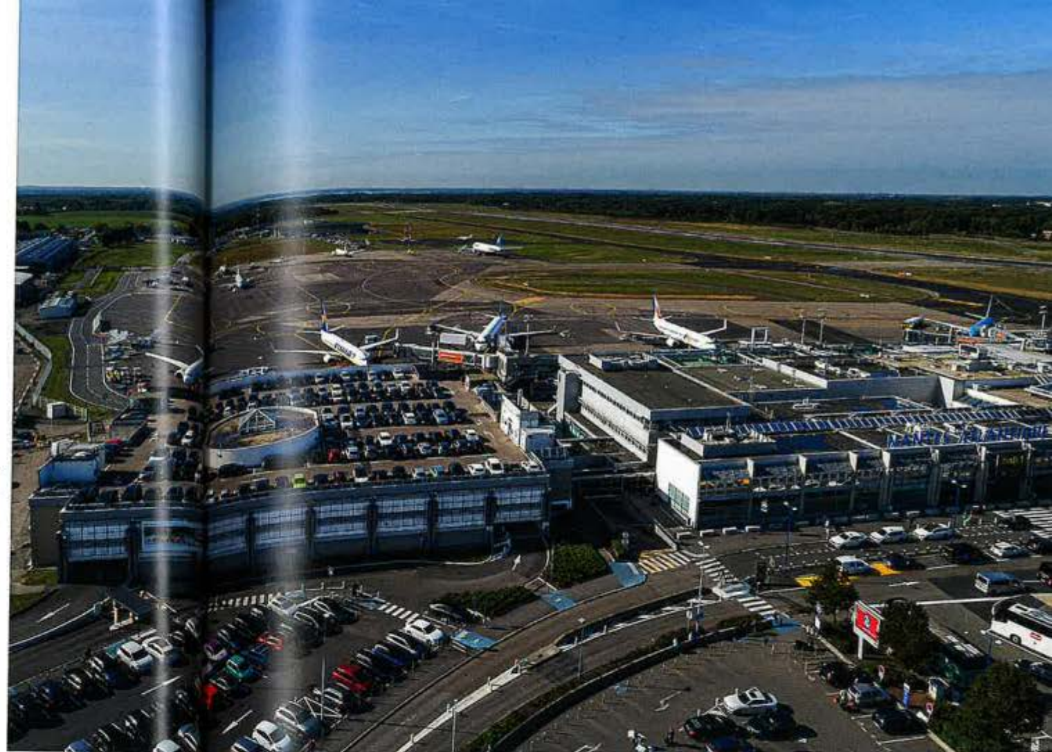
Vue aérienne de l'aéroport de Nantes-Atlantique. Une infrastructure aux enjeux territoriaux multiples : socio-économie ; nuisances sonores ; qualité de l'air et santé ; milieux naturels et climat, etc.
