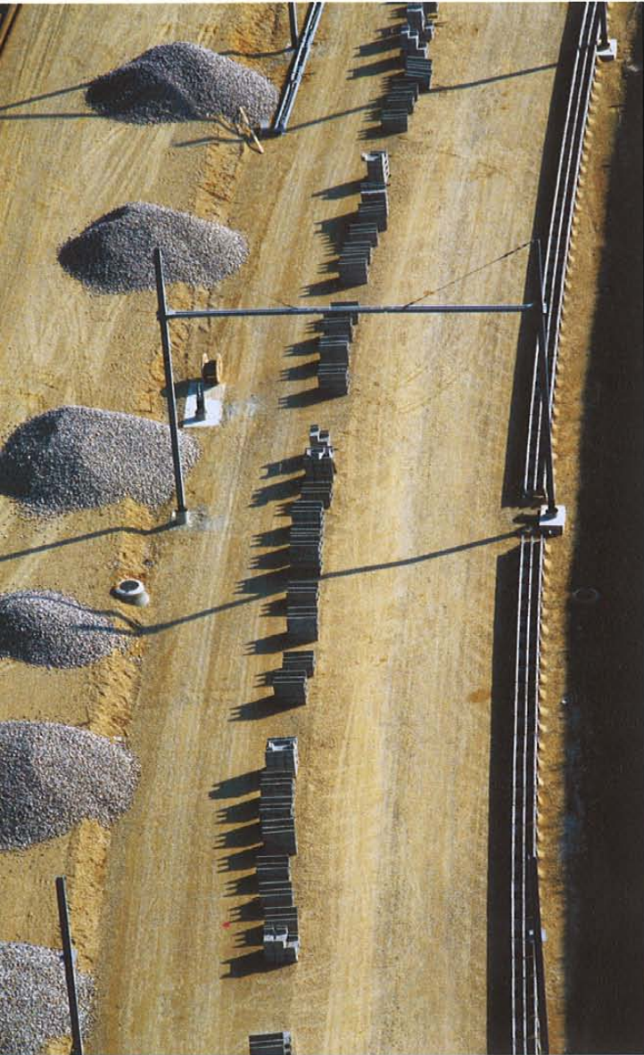
❖ Chantier du RER à Torcy, ca 1978.
