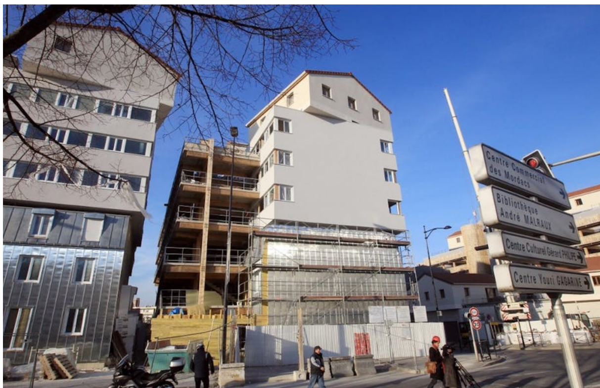
Projet architectural dessiné en 2012 par Edouard Francois à Champigny-sur-Marne (94), commune du 'Grand Paris' au coeur de nombreux projets de rénovations urbaines. PIERRE VERDY / AFP
