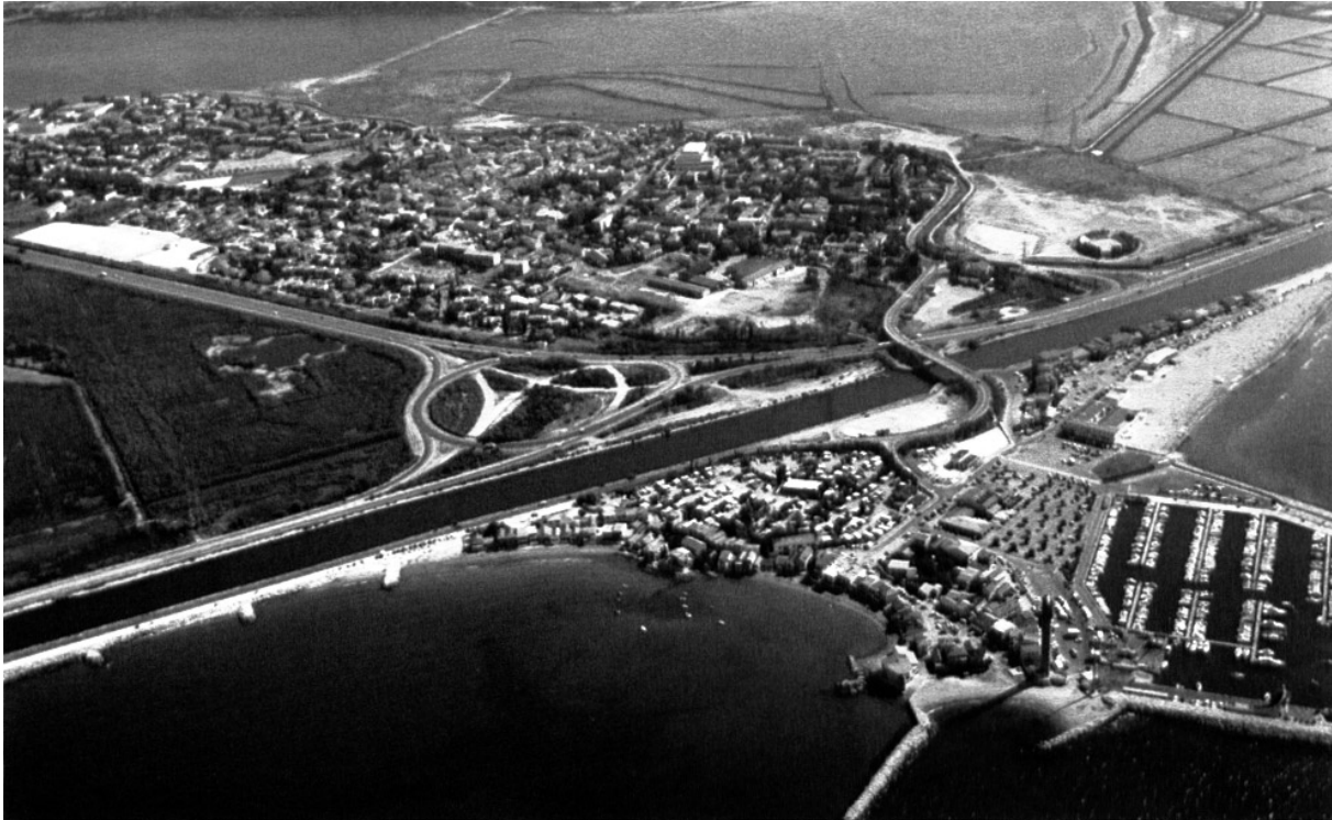
Terminal pétrolier, Fos-sur-Mer
